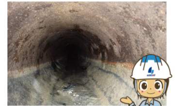
管内洗浄後の管内
