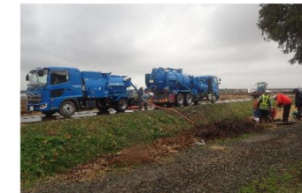
管内洗浄作業のようす
